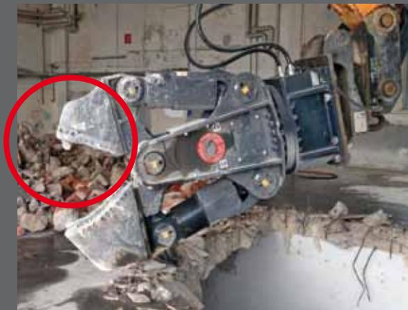
Die massive Bauweise ist für den täglichen Einsatz ausgelegt. Das Universalgebiss kann Stahlbeton bis zu einer Stärke von 800 mm zerschneiden.
